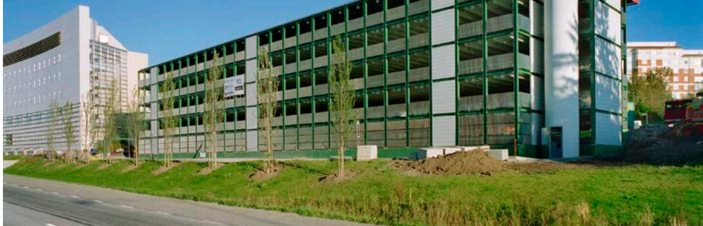
SEB Rissne Adress: Ulvsundavägen Ort: Sundbyberg Arkitektkontor: Rosenbergs Arkitekter Byggherre: Skandinaviska Enskilda Banken Byggår: 1997 Tillbyggnad: 2008 Yttervägg: Beklädnadselement, glas Fasadyta: Betongelement i vit betong
